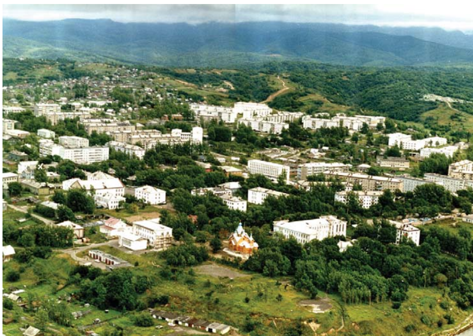
Рис. 7. Современный Александровск, из Фонда историко-литературного музея «А. П. Чехов и Сахалин», г. Александровск-Сахалинский
