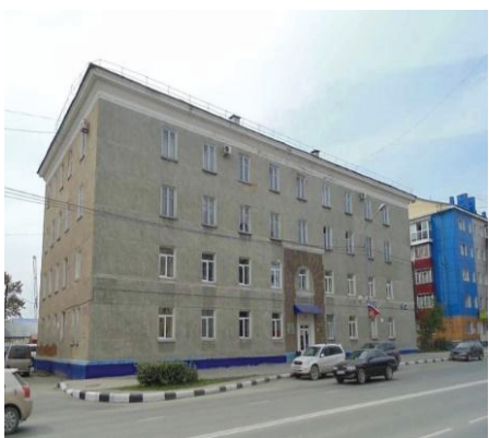
Рис 3. Внешний вид корпуса № 5 (современный)
