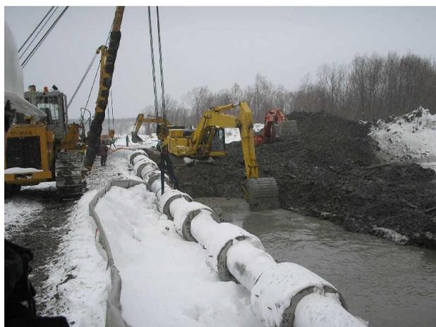
**Рис. 1.** Река Ай – строительство перехода нефтегазопровода, рытье траншеи, 2006 г. (источник: официальный сайт «Сахалин Энерджи» [www.sakhalinenergy.com](http://www.sakhalinenergy.com))
