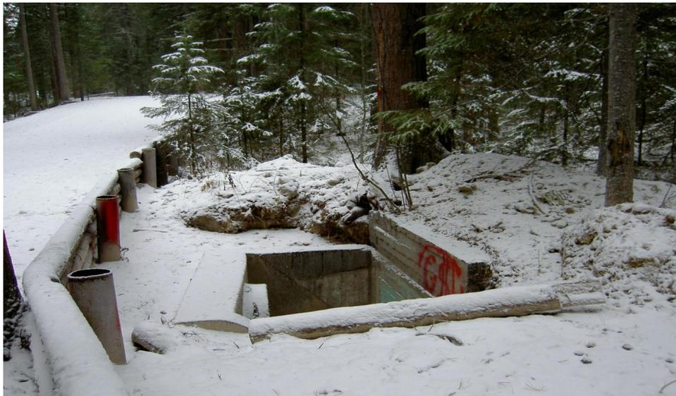
Рис. 2. Водопрпускное сооружение построено рядом с логом и не пропускает воду
