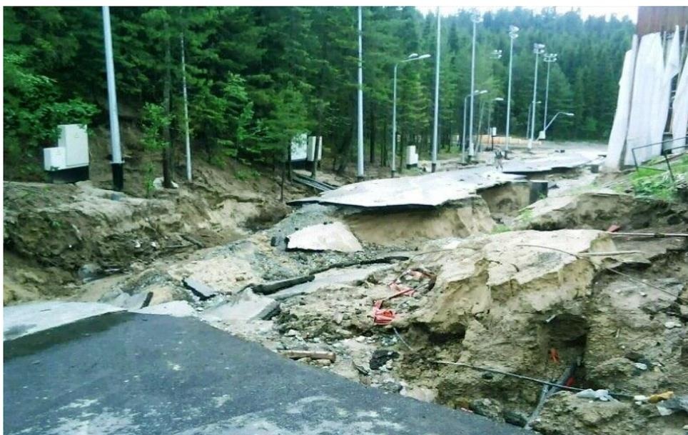
Рис. 1. Разрушение полотна биатлонной трассы
