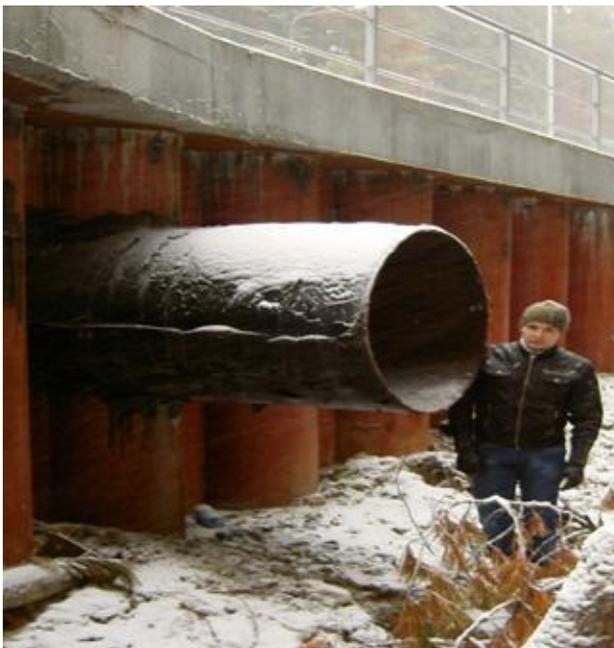
Рис. 3. Водопрпускная труба на расстоянии 155 см от днища лога
