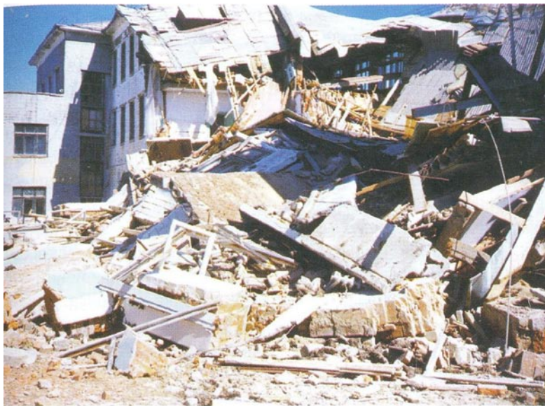
Рис. 2. Разрушенная при землетрясении школа, п. Нефтегорск, 1995 г. [5]
