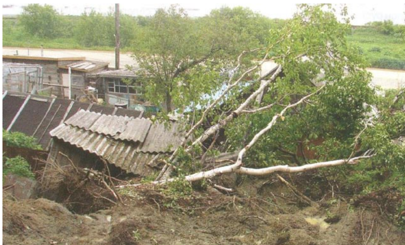
Рис. 3. Последствия схода оползня [6]
