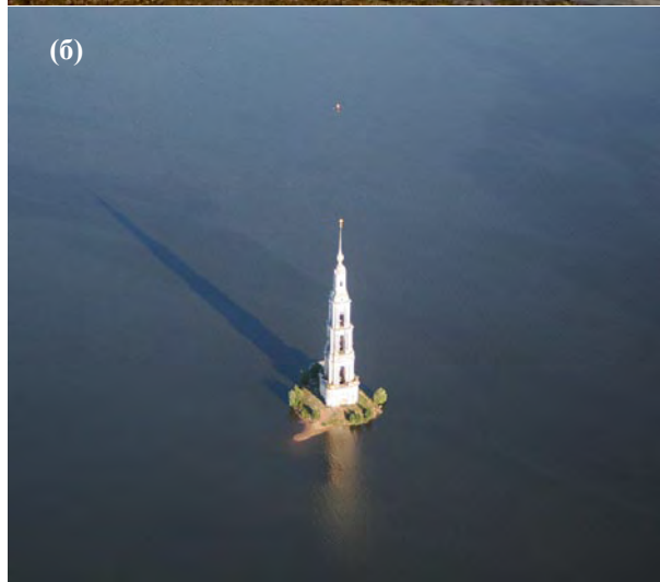
Фото 2.4. Колокольня Никольского собора Калязинско-Троицкого монастыря (а) с 1930-х годов стала островом (б) Угличского водохранилища (фото А. Щербакова).
