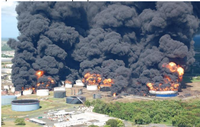
Рис. 38 — Авария на пожаровзрывоопасном объекте
